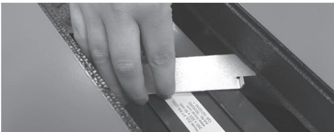
4. Verschmutzte Filter herausziehen. Filterhalterung auf der montierten Seite belassen.
