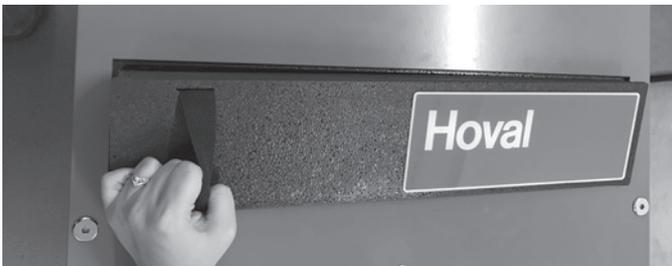
3. Filterhalterung durch eine 90° Drehung entfernen (sofern vorhanden)
