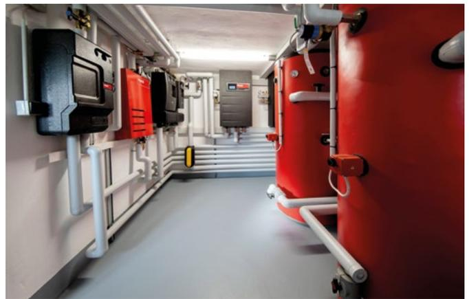
Wo Öltanks aufgebaut waren, steht nun ein komplett neues System aus Wärmepumpen-Kaskaden, TransTherm®-Modulen und Wasserspeicher.
