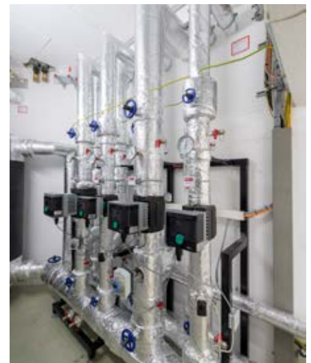
Der Heizungs- und Kälteverteiler TransShare sorgt für eine effiziente Energieverteilung.
