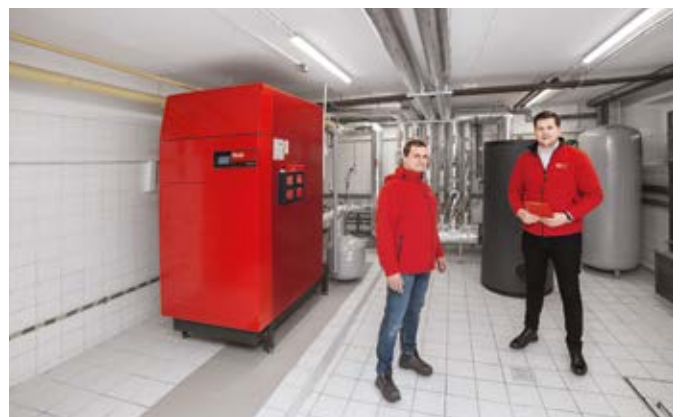
Service Partner Marcin Orpiszewski und Michał Duliban haben das Projekt im Gymnasium realisiert.
